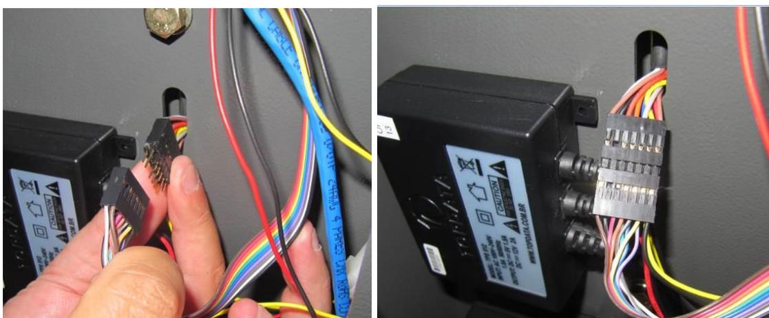
**Passo 8:** Uma vez que o cabo está devidamente conectado e com o comprimento adequado, as cintas existentes na parte traseira podem ser conectadas e apertadas:
